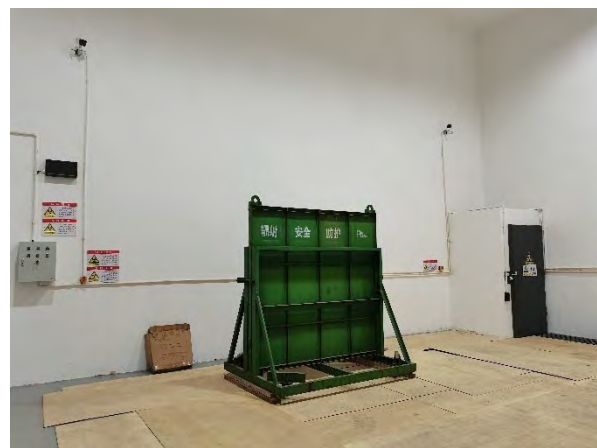
γ 射线探伤室急停按钮照片
