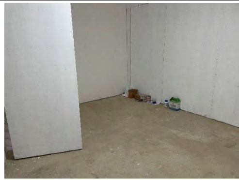
控制室上方储物间 2
