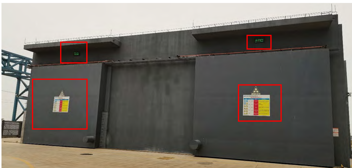
X 射线探伤室和 \gamma 射线探伤室大防护门电离辐射警示标志和警示灯
