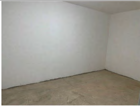
控制室上方储物间 1
