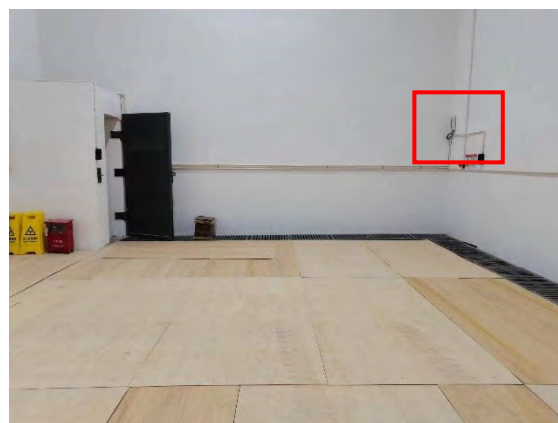
源库固定式辐射检测探头
