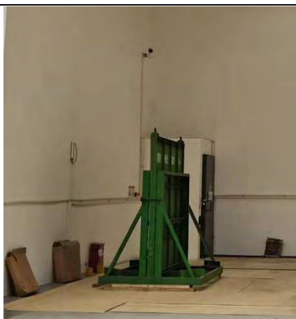
\gamma 射线探伤室固定式辐射检测探头
