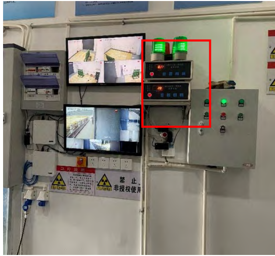
\gamma 射线探伤室、源库固定式辐射检测系统剂量率水平显示仪器
