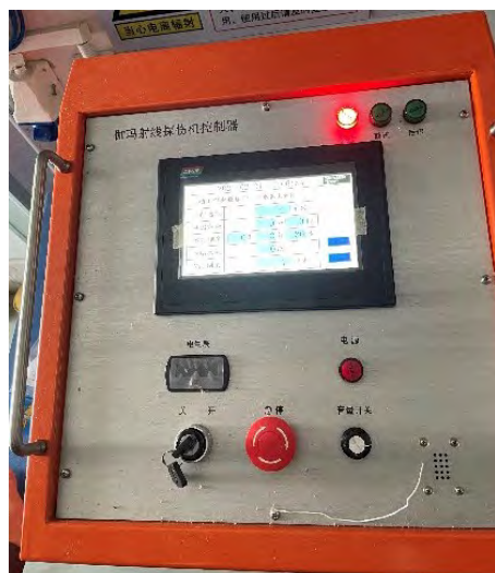
γ 射线探伤机控制端出束状态指示灯
