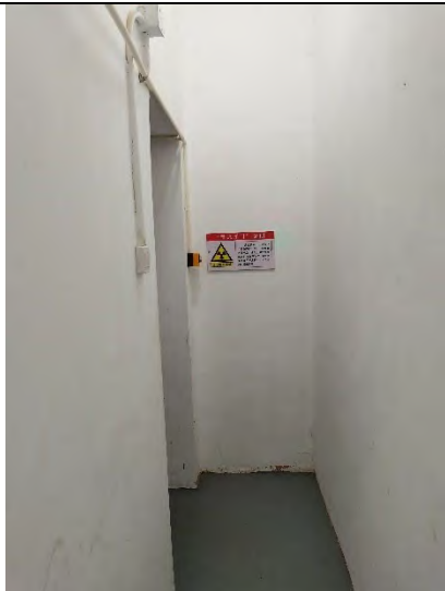
X 射线探伤室急停按钮照片
